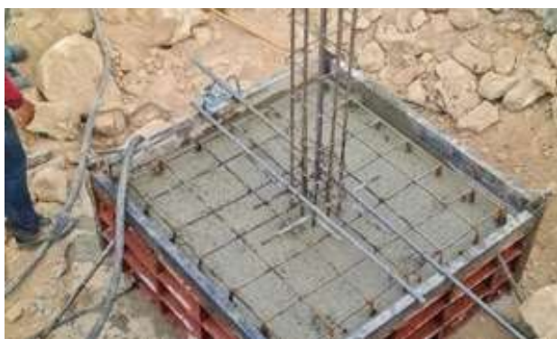
Teräsbetoni on vahvistettu terästangoilla.
